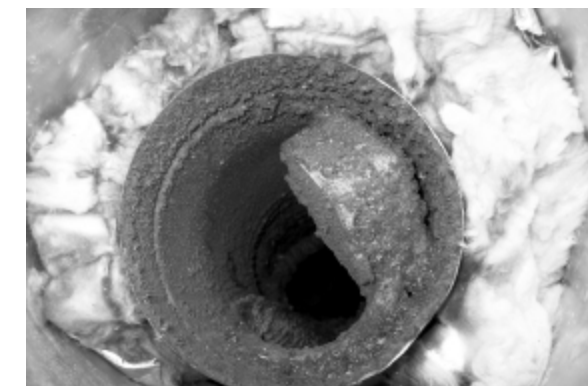
Oben: Blick mit der Videokamera in den Lüftungsschacht. Mitte rechts: Auf dem Monitor ist zu sehen: überall dicke Ablagerungen. Mitte links: Vorbereitung zum Abzugstest mit einer kleinen Rauchgaspatrone. Unten links: Eine Kelle voll Ablagerungen, idealer Nährboden für Schimmelpilze. Unten rechts: Überraschung auf dem Dach. Im Abzugsschacht ist eine TV-Antenne samt Verteilerdose verlegt worden.
