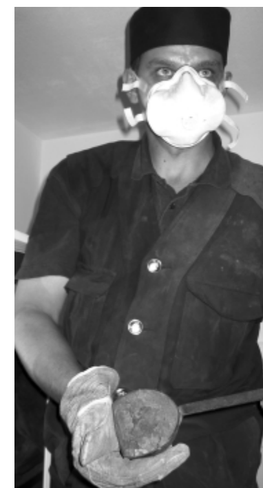
Oben: Blick mit der Videokamera in den Lüftungsschacht. Mitte rechts: Auf dem Monitor ist zu sehen: überall dicke Ablagerungen. Mitte links: Vorbereitung zum Abzugstest mit einer kleinen Rauchgaspatrone. Unten links: Eine Kelle voll Ablagerungen, idealer Nährboden für Schimmelpilze. Unten rechts: Überraschung auf dem Dach. Im Abzugsschacht ist eine TV-Antenne samt Verteilerdose verlegt worden.
