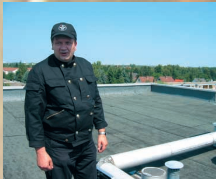
Schornsteinfegermeister Hartmut Putbrese: „Leider sind viele Lüftungsanlagen in Berliner Mietshäusern schlecht gewartet.“
