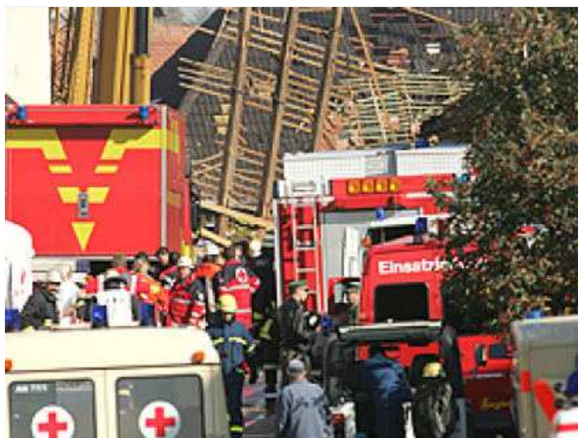
Gas-Explosion in Lehrberg: Im Hintergrund die zusammengefallene Bäckerei © Thomas Langer/AP
